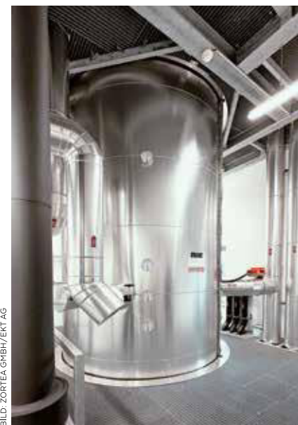
1 | Blick auf die mittlere Ebene des Zortström-Verteilers
