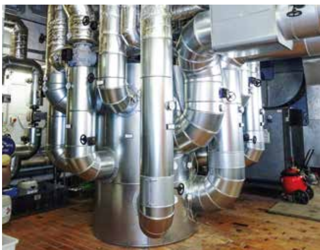
4-stufiger ZORTSTRÖM Multi für die Heizung Zwei ZORTSTRÖM Multi (2- und 3-stufig) für die Kühlung
