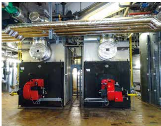
Die Kessel blieben bei der Sanierung unverändert.
