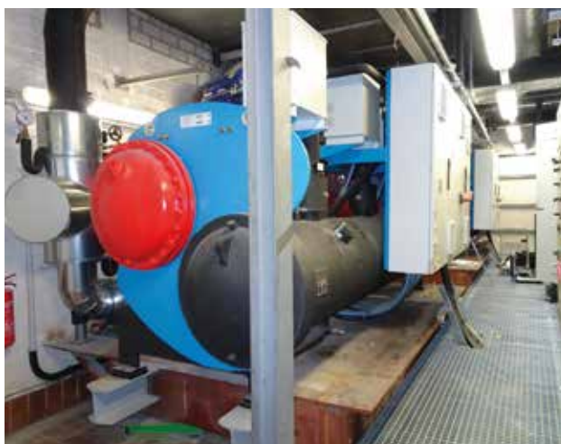
Die Kühlmaschinen wurden zum Teil erneuert.
