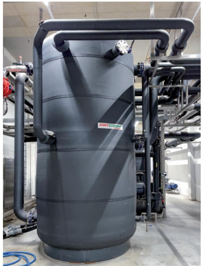
Geplant und gebaut für Großlösungen mit hohem Effizienzpotenzial: eine 5-stufiger Zortström-Anlage mit einem Volumen von 15,5 m<sup>3</sup>
